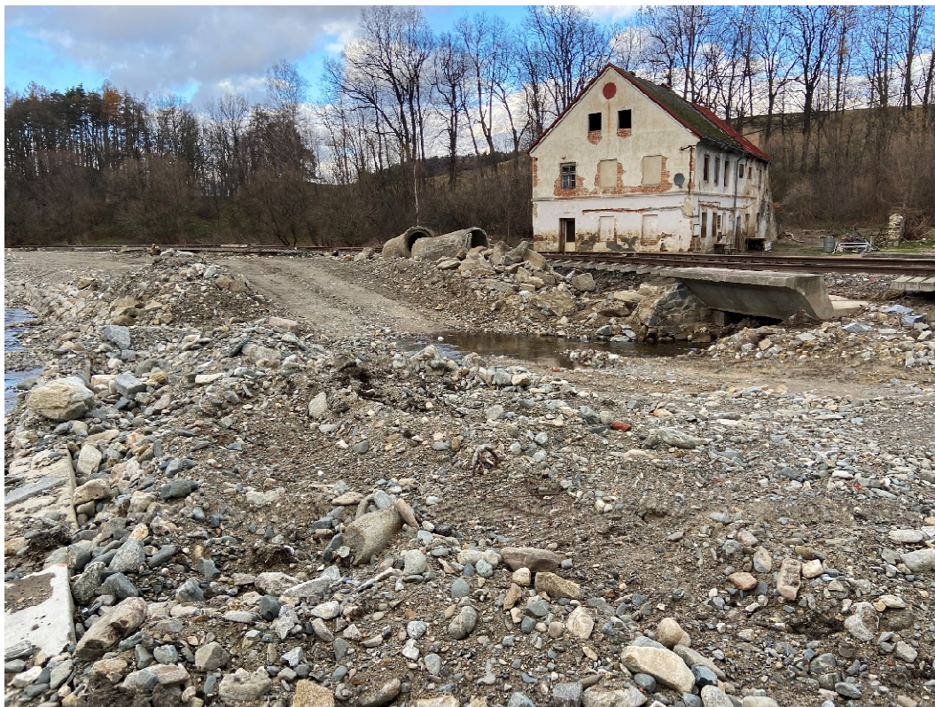
Obrázek 4 - poškozený propustek a drážní těleso – pohled od Vidnávky
