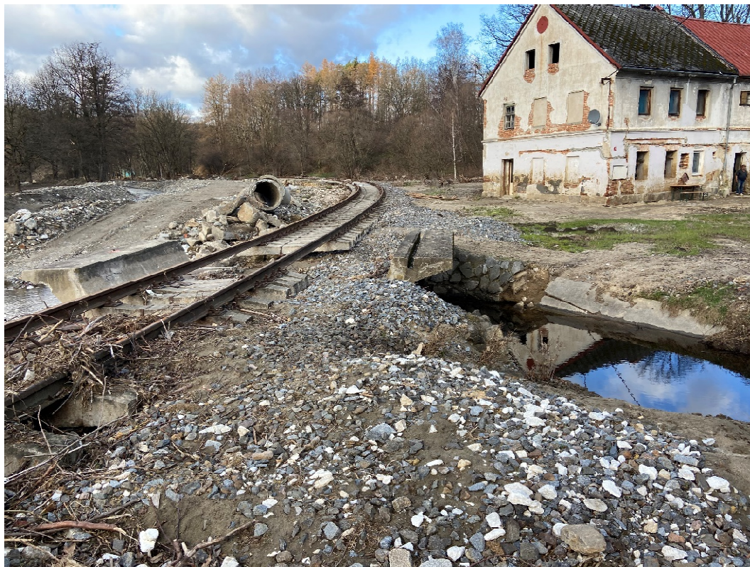
Obrázek 3 – poškozený násep, Kobylá. Pohled na propustek evid. km 18,268
