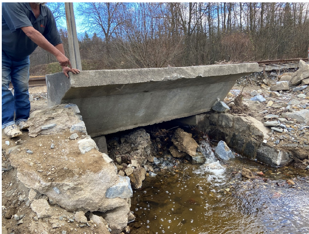
Obrázek 9 - pohled na výtok původního propustku zcela zaneseného sedimenty z povodňové události
